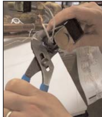
Loosening the conduit nut
