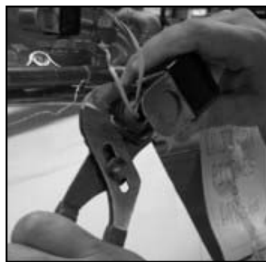
Loosening the conduit nut
