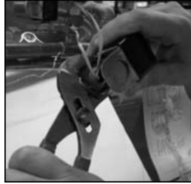
Loosening the conduit nut
