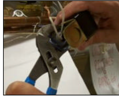
Loosening the conduit nut
